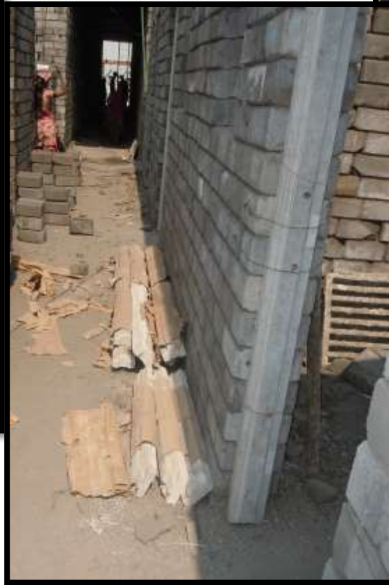
DOOR FRAMES & STAIRCASE
